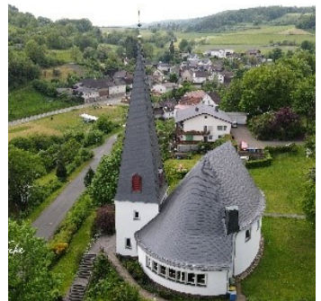
Ev. Kirche Wommelshausen Höhenstraße 38 35080 Bad Endbach
